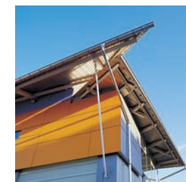
Stahlunterkonstruktion für Fassadenelemente und als Stütze für verschiedene Sektionaltore
