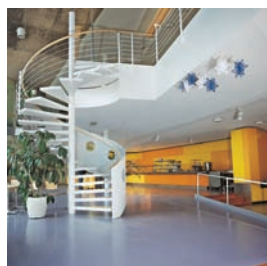
Wendeltreppe mit Ahorn-Handläufen, teilweise mit Relinggeländer mit individuellem Lochdesign, geschlossenen Stahlrohren mit eingelassenen Holzstufen
