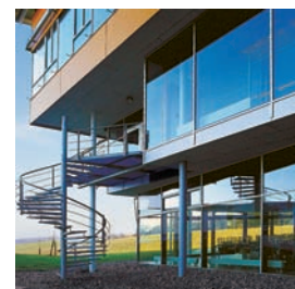
Galvanisierte Außentreppe mit Gitterstufen
