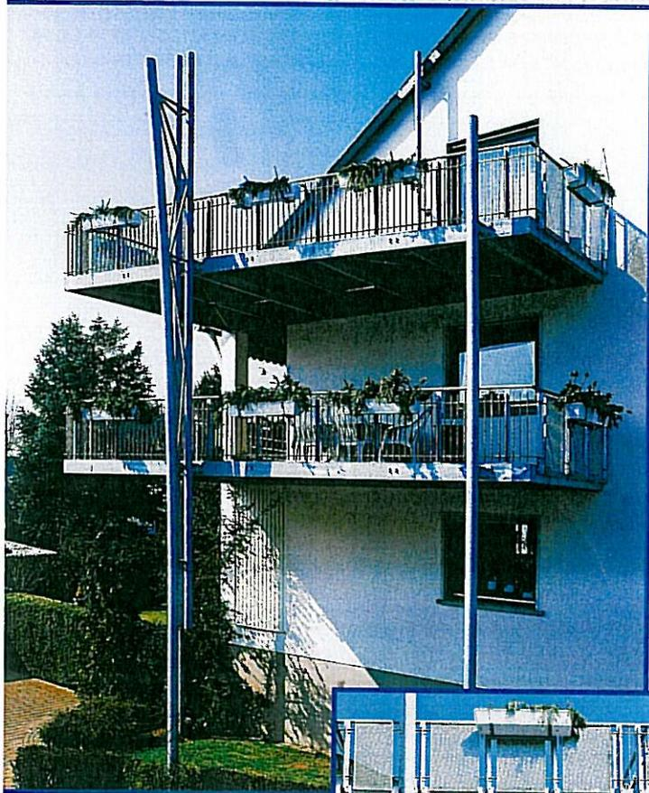
**Zweigeschossige Balkonanlage aus feuerverzinktem Stahl und lesigter Fachwerkstütze**
